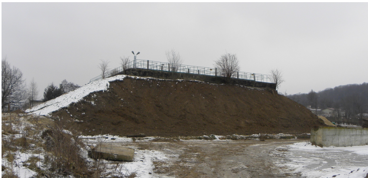
Zdjęcie nr 11 Wyburzony zbiornik Imhoffa
