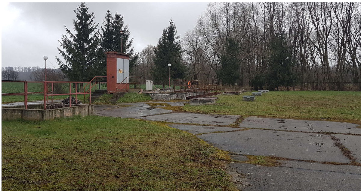
Zdjęcie nr 19 Pompownia ścieków Z-3 przy ul. Legnickiej przed modernizacją
