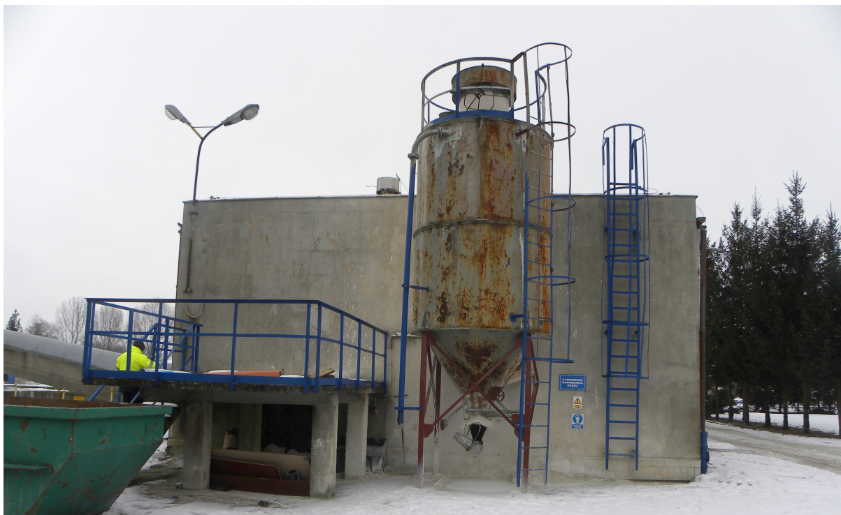
Zdjęcie nr 15 Budynek odwadniania osadów przed modernizacją
