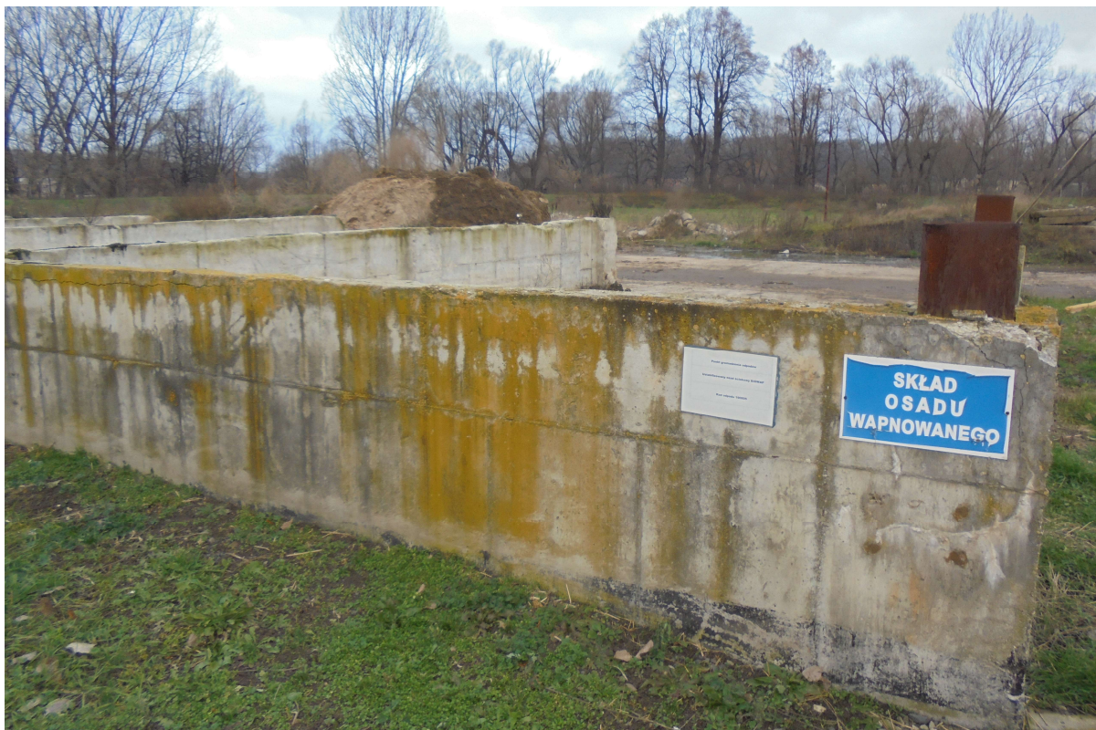
Zdjęcie nr 17 Plac składowania osadu odwodnionego przed modernizacją
