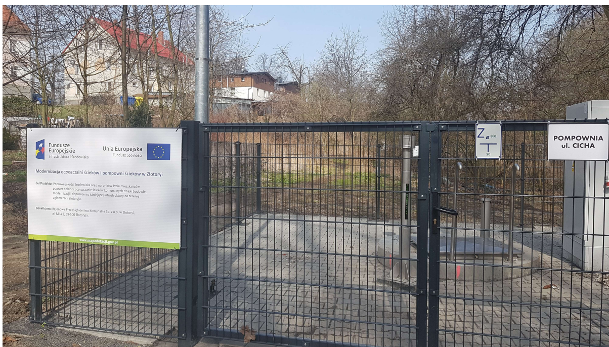
Zdjęcie nr 24 Pompownia ścieków przy ul. Cichej po modernizacji
