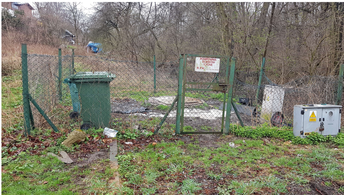
Zdjęcie nr 23 Pompownia ścieków przy ul. Cichej przed modernizacją
