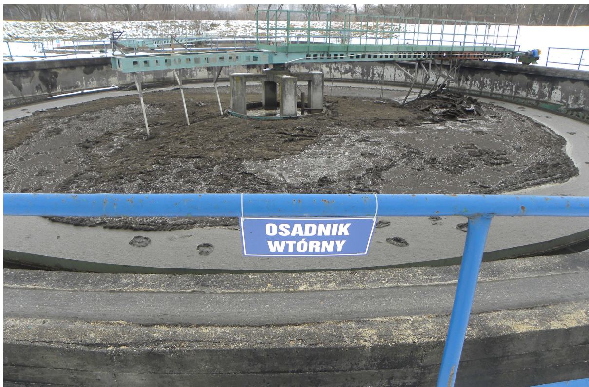
Zdjęcie nr 7 Osadniki wtórne przed modernizacją
