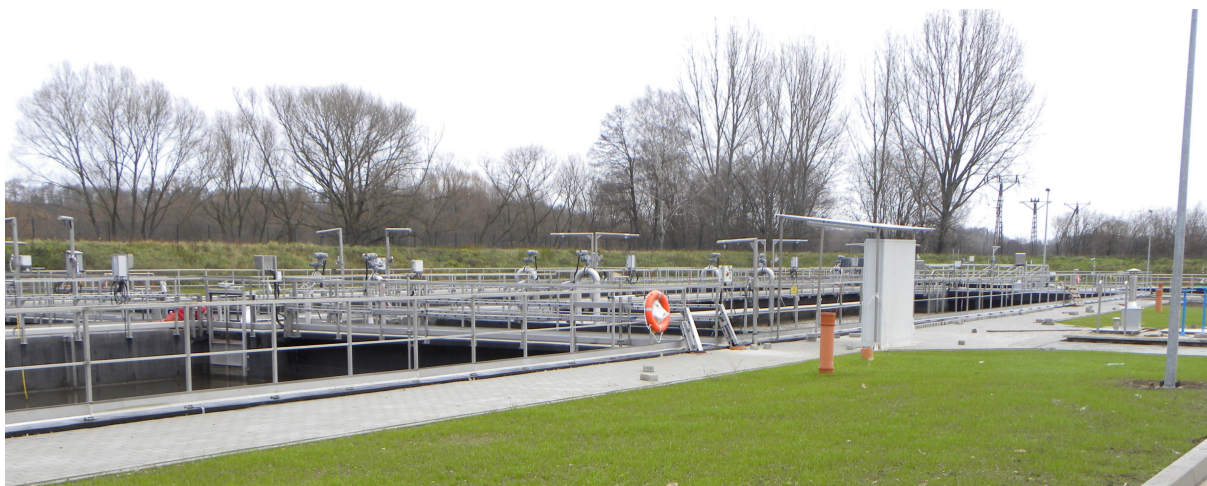
Zdjęcie nr 6 Blok biologiczny po modernizacji
