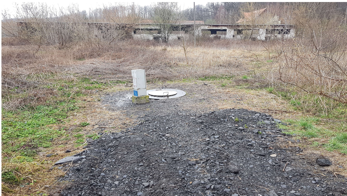
Zdjęcie nr 35 Pomownia ścieków przy ul. Łąkowej II przed modernizacją
