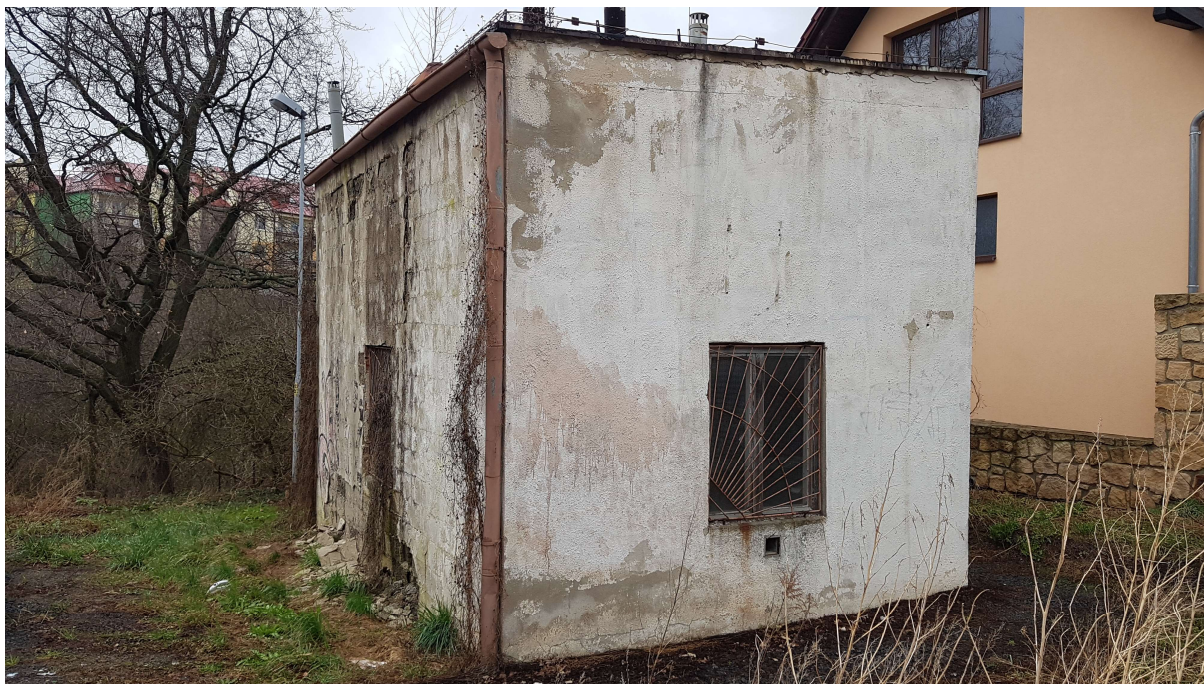
Zdjęcie nr 25 Pompownia ścieków przy ul. Odrzańskiej przed modernizacją
