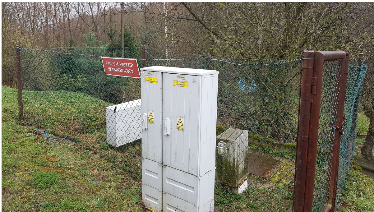
Zdjęcie nr 31 Pompownia ścieków przy ul. Piastowej II przed modernizacją
