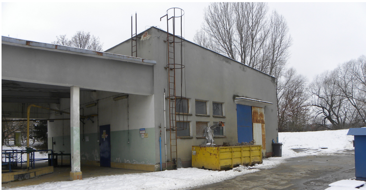
Zdjęcie nr 1 Budynek krat i piaskowników przed modernizacją
