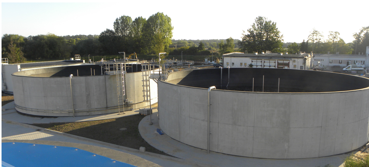
Zdjęcie nr 12 Komory tlenowej stabilizacji osadu
