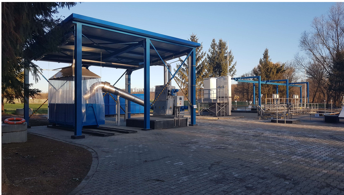
Zdjęcie nr 21 Pompownia ścieków Z-3 przy ul. Legnickiej po modernizacji
