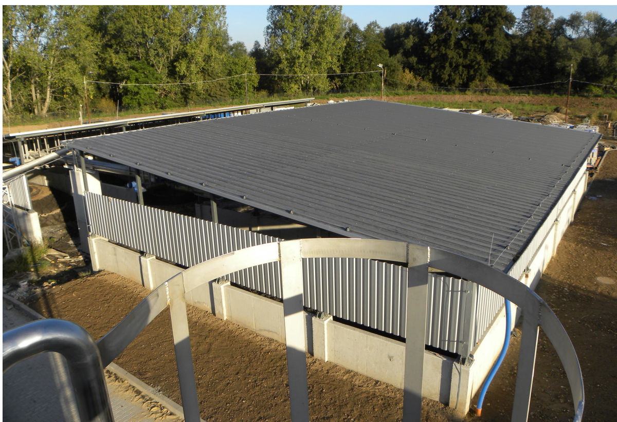
Zdjęcie nr 18 Plac składowania osadu odwodnionego po modernizacji
