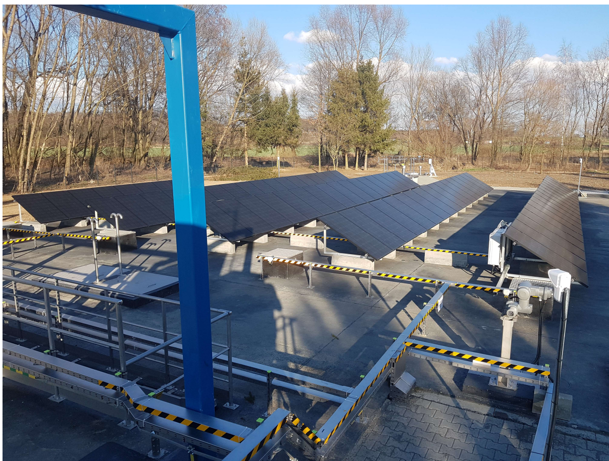
Zdjęcie nr 22 Pompownia ścieków Z-3 przy ul. Legnickiej po modernizacji
