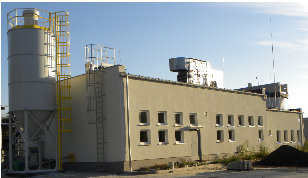
Zdjęcie nr 16 Budynek odwadniania osadów po modernizacji
