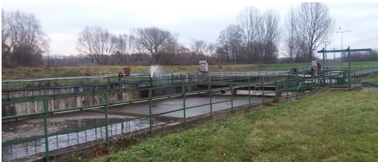
Zdjęcie nr 5 Blok biologiczny przed modernizacją
