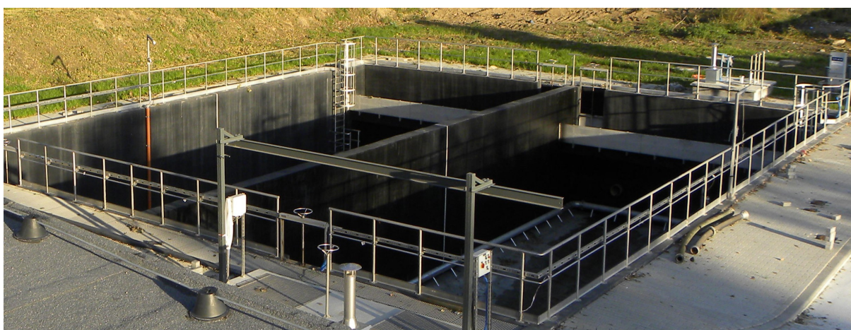
Zdjęcie nr 4 Zbiornik retencyjny po modernizacji
