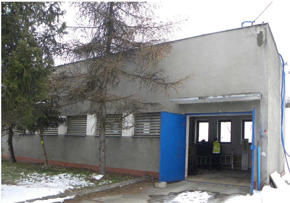
Zdjęcie nr 13 Budynek stacji transformatorowej i dmuchaw przed modernizacją
