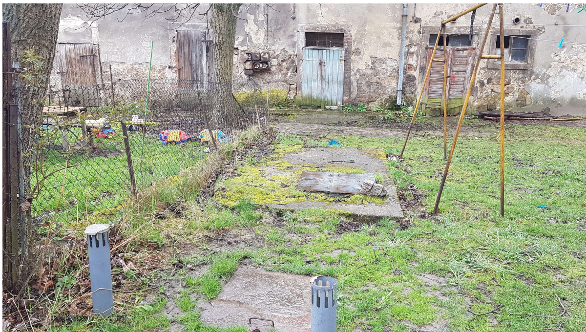
Zdjęcie nr 29 Pomownia ścieków przy ul. Piastowej I przed modernizacją
