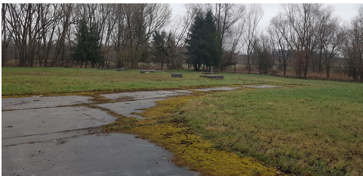
Zdjęcie nr 20 Pompownia ścieków Z-3 przy ul. Legnickiej przed modernizacją
