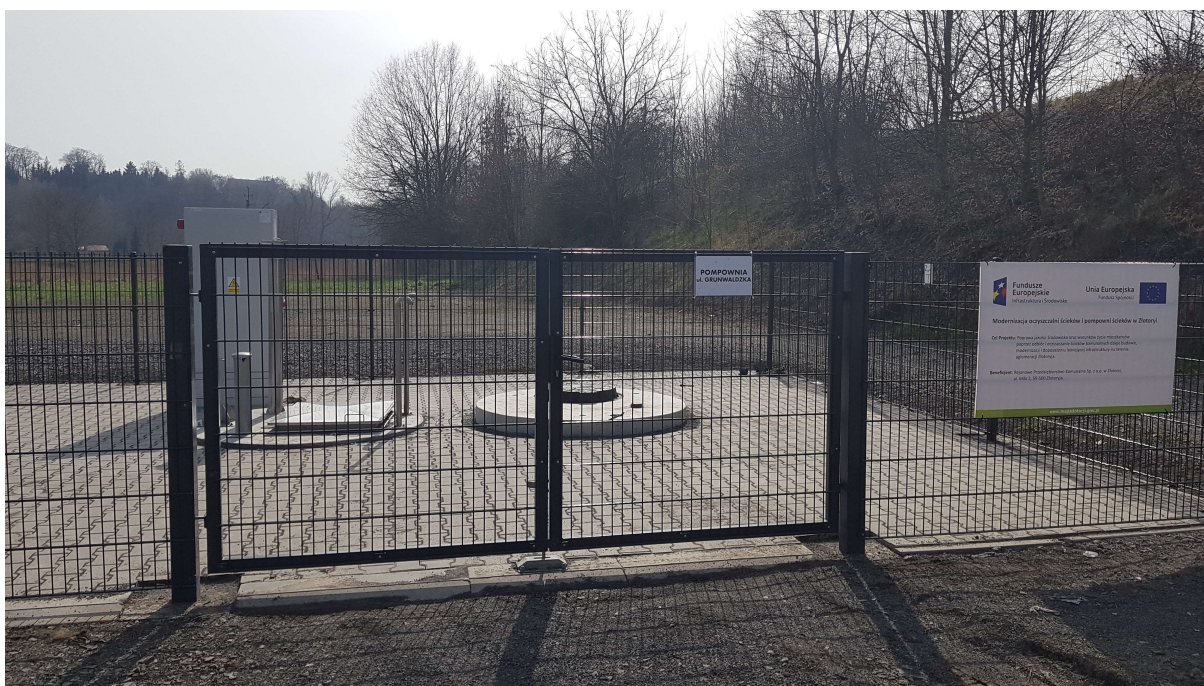
Zdjęcie nr 28 Pompownia ścieków przy ul. Grunwaldzkiej po modernizacji
