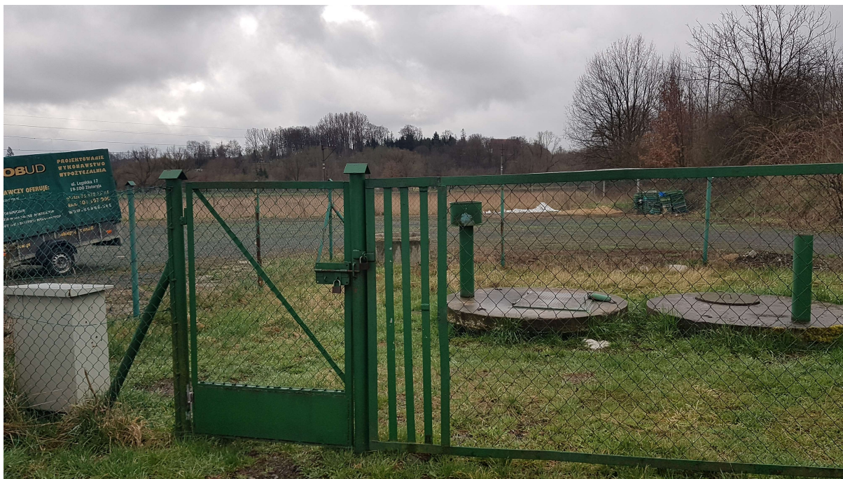
Zdjęcie nr 27 Pompownia ścieków przy ul. Grunwaldzkiej przed modernizacją
