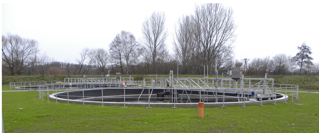
Zdjęcie nr 8 Osadniki wtórne po modernizacji
