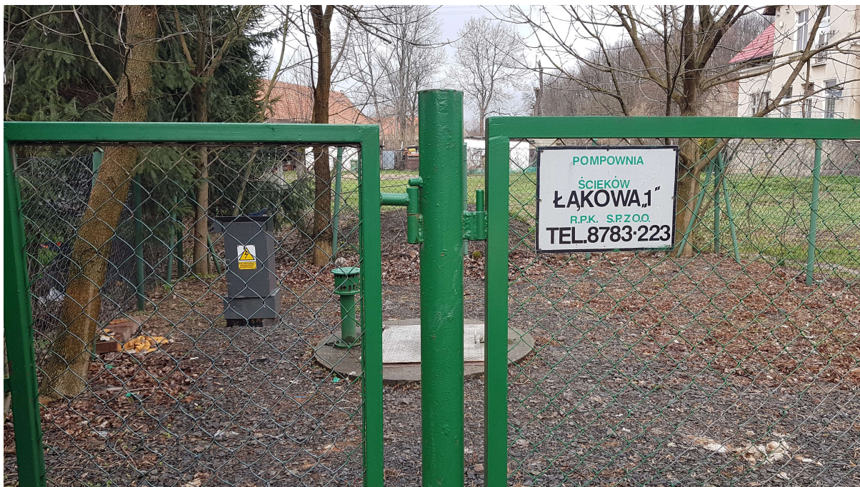
Zdjęcie nr 33 Pompownia ścieków przy ul. Łąkowej I przed modernizacją
